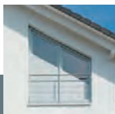
Der S, mit direkt auf der Fensterbank liegendem Kasten, der Rollladen läuft von unten passgenau in die Schräge
